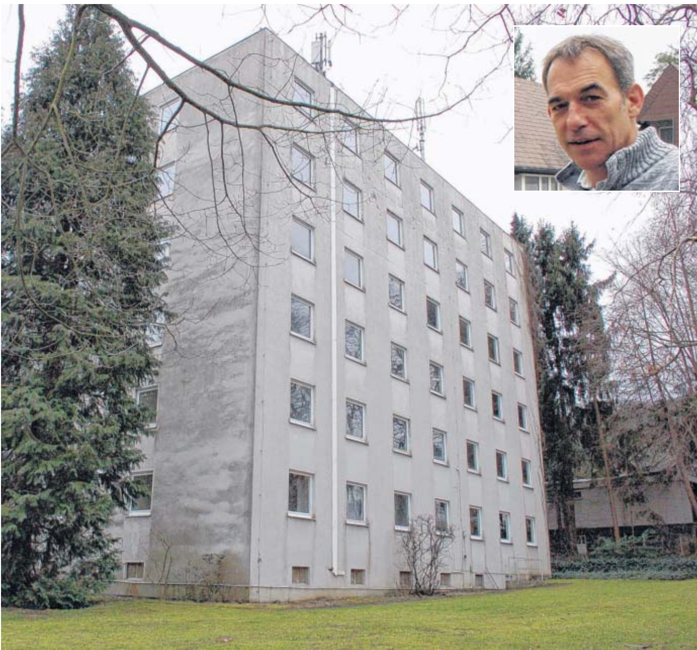
Ehemaliges Studentenwohnheim: Die Stadt kauft das leerstehende Gebäude an der Louis-Flotho-Straße und lässt es für die Nutzung als Asylbewerberheim sanieren. Ratsmitglied Berno Schlanstedt reagierte auf Kommentare zu dieser Entscheidung.
